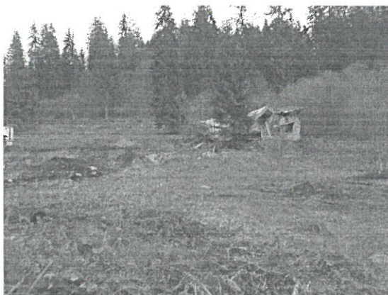
VILA Nr. 18- demolată
